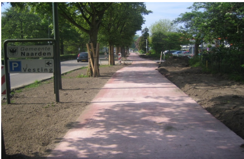
Mooi voorbeeld: Bij wegwerkzaamheden Amersfoortsestraatweg, wordt tegelfietspad vervangen door cementbeton
